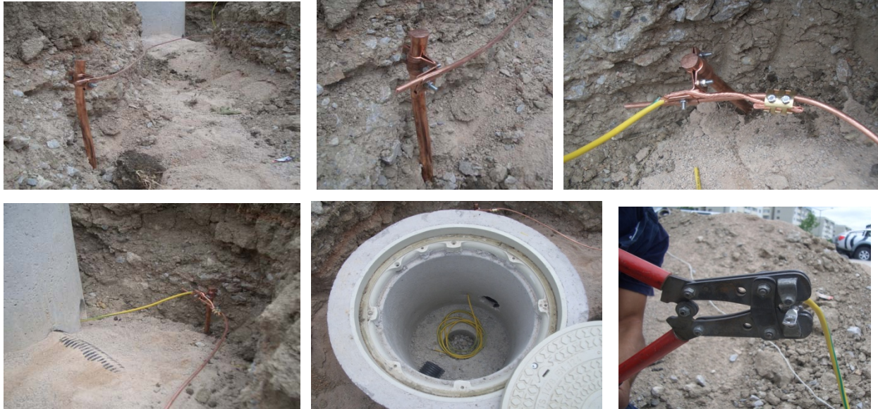
Şekil-17 Topraklama çubuğu montajı
