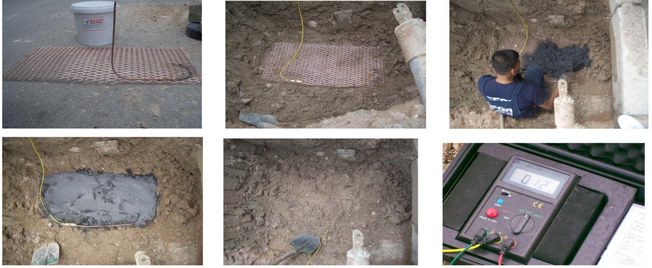
Şekil-18 Bakır hasır ile topraklama
