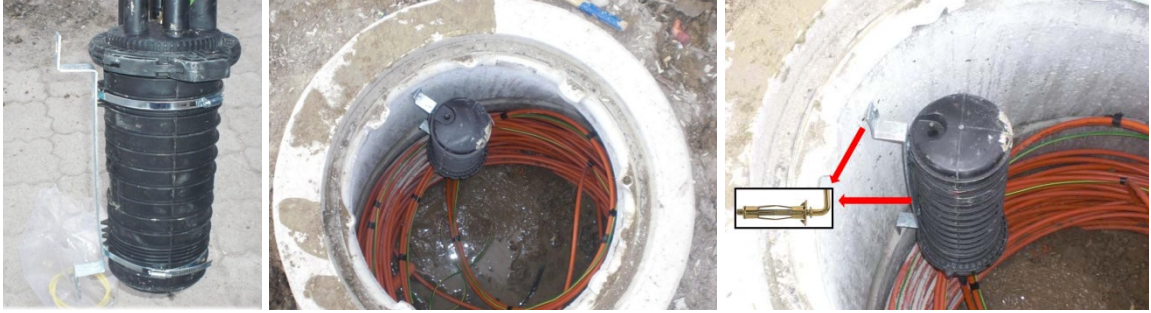
Şekil-3 Fiber optik kablo ek kutusunun ek odasına montajı
